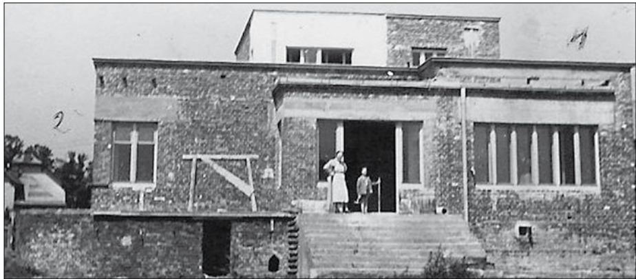
Budowa nowego domu państwa Druks
