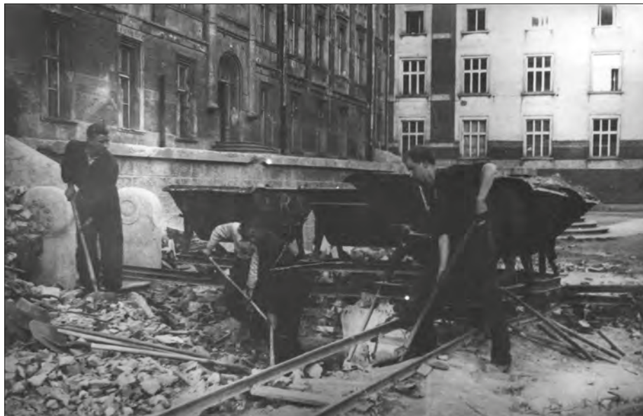
Fot. 16. Oświęcim, czerwiec 1947. Młodzież z zapałem bierze się do dzieła i w wolnych chwilach ładuje gruz na wózki, by uprzętnąć boisko, a jednocześnie zabezpieczyć mury zakładu przed zawilgoceniem
