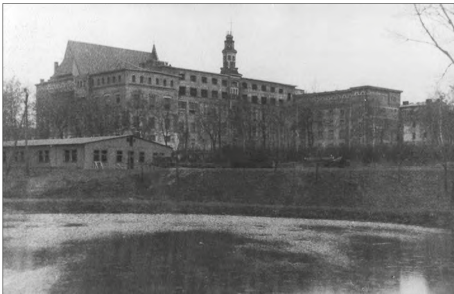
Fot. 9. Widok zakładu po odbudowie – nadbudowie dwóch pięter
